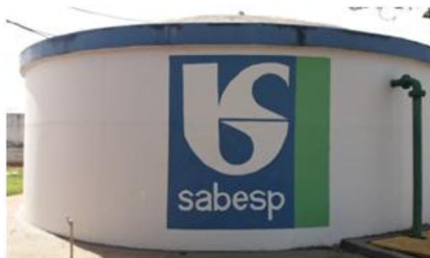
Vista do reservatório apoiado de Lupércio - Sede
