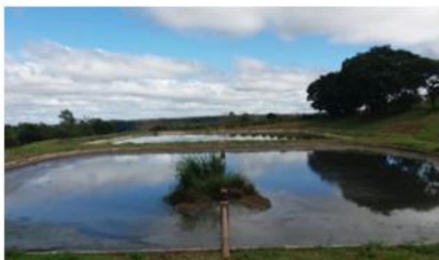
Vista da ETE de Lupércio - Sede
